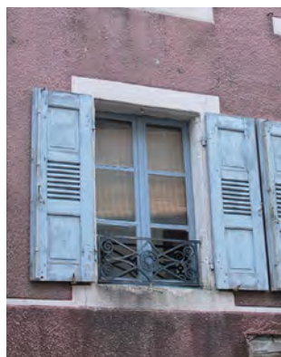
Baie aux proportions plus hautes que larges avec allège surbaissée et garde corps en ferronnerie
