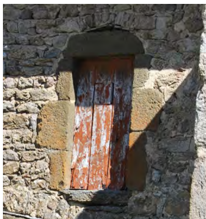
Sassac, encadrement en granite et arc de décharge
