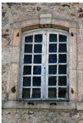
Encadrements de baie en pierre de taille avec linteau cintré
