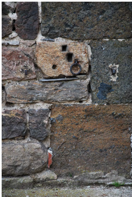
Grande variété des pierres utilisée pour la réalisation des différents éléments constituant la maçonnerie (lindeau, piédroit, blocage, chaîne d'angle) en fonction de leurs propriétés.
