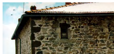
Diversité des matériaux de maçonnerie puisés dans le sous-sol
