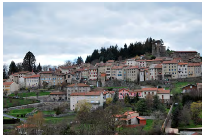
Progressivement les couleurs des façades se sont ternies avec l'altération des badigeons, des enduits et le décroûtage de nombreux immeubles.
