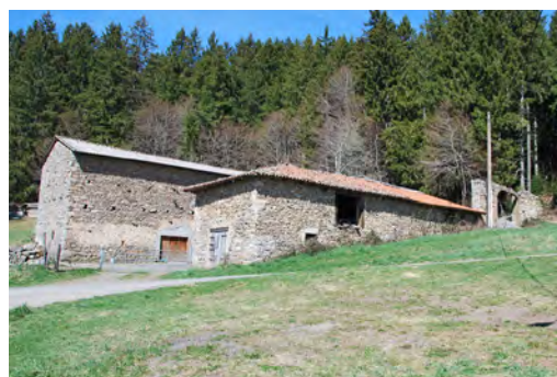
Chabannes, remarquable implantation dans la pente
