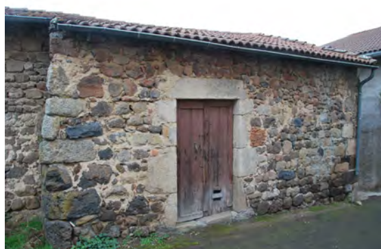
Les bâtiments annexes sont bâtis avec le même type de pierres et de maçonnerie (sur cet grange, les chaînes d'angle sont particulièrement imposantes) mais n'étaient généralement pas enduites.
