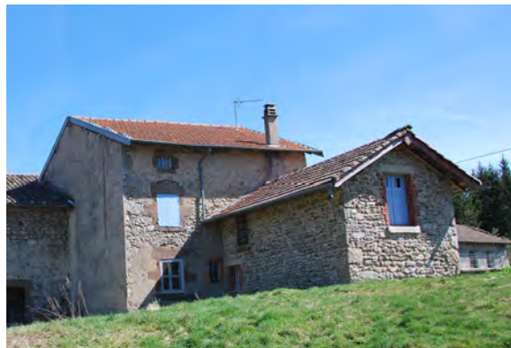
Sassac, diversité des tuiles utilisées à Allègre (canal et mécaniques plates)
