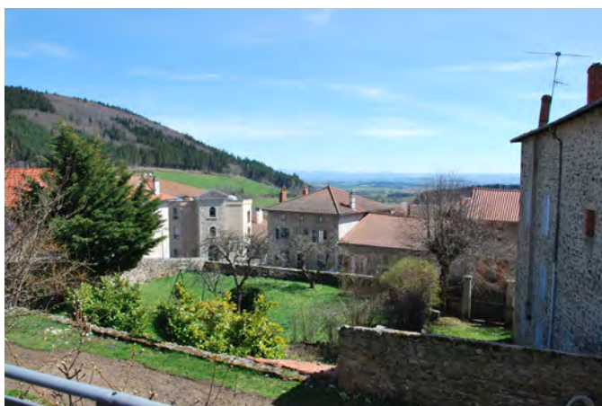
Soutènements et murs de clôture sous le château
