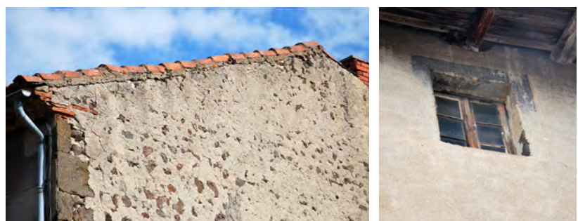
Joints à pierre vue sur les pignons et enduits (avec généralement des décors peints sur les façades principales)
