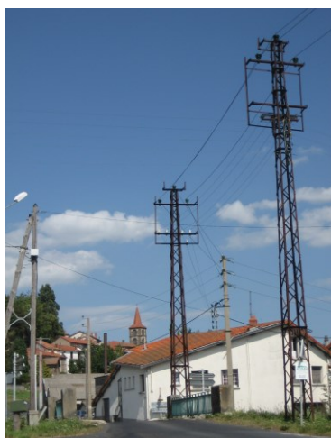
rue des Potelleries avant
