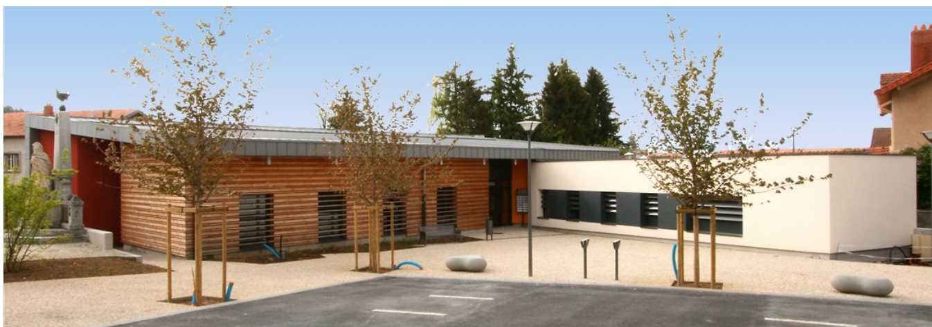
Maison de santé pluridisciplinaire à l'entrée Sud d'Allègre
